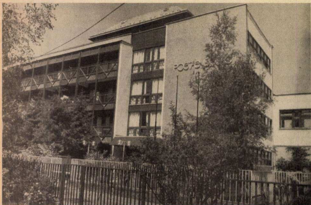
A felújított régi szárny utcai homlokzata
